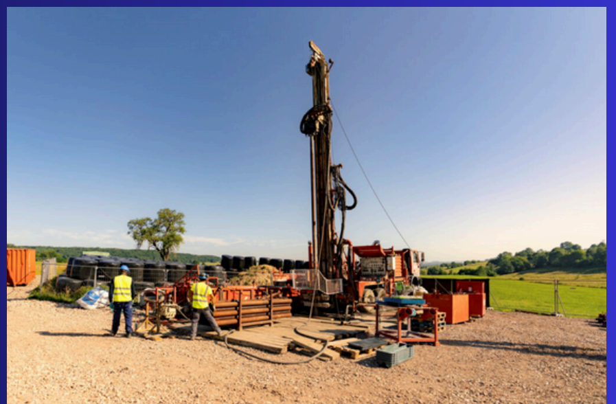
figuur 3: grondboringen om de grond te testen voor de Einsteintelecoop.
